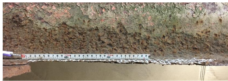
写真7 下フランジ腐食欠損状況(下流側)
