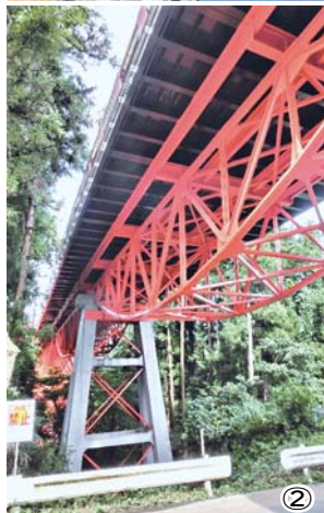
② 奥多摩橋の側方に弧を描く魚腹トラス橋(写真②)。
