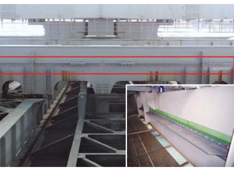
TRSを使った補強後の櫃石島橋(T字形材は写真赤囲部)
