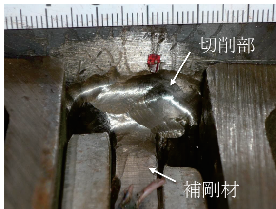
写真-12 C断面ステップ3(1), 事後保全対策(その2)の施工状況
