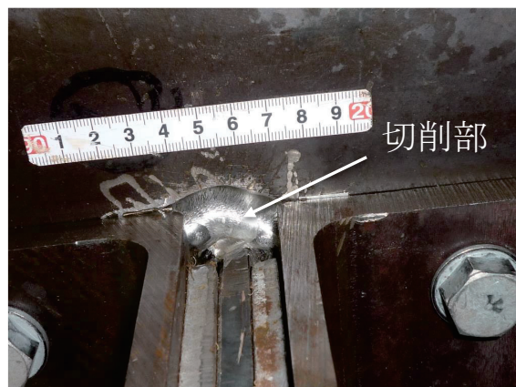
写真-6 A断面ステップ2, 事後保全対策 (その1) の施工状況
