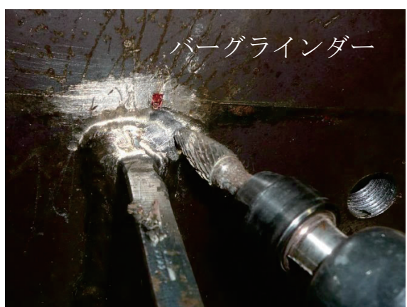
写真-10 C断面ステップ3(1), バークラインダーを用いた切削状況
