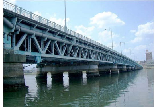
写真1 国道2号 淀川大橋
