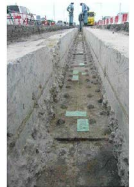
写真2 事前の上フランジ確認
