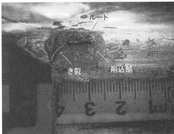
写真14 き裂先端削り込み状況, 試験部 A (N=70 万回)
