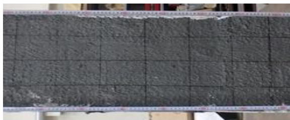
写真 8 試験体平面の変形状況 (年温度変化，16 回目，試験終了時)
