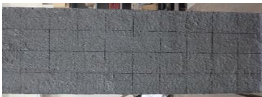
写真 3 試験体平面の変形状況 (日温度変化, 载荷回数 6000 回, 試験終了時)
